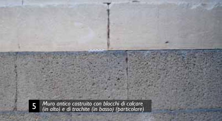
**5** Muro antico costruito con blocchi di calcare (in alto) e di trachite (in basso) (particolare)
