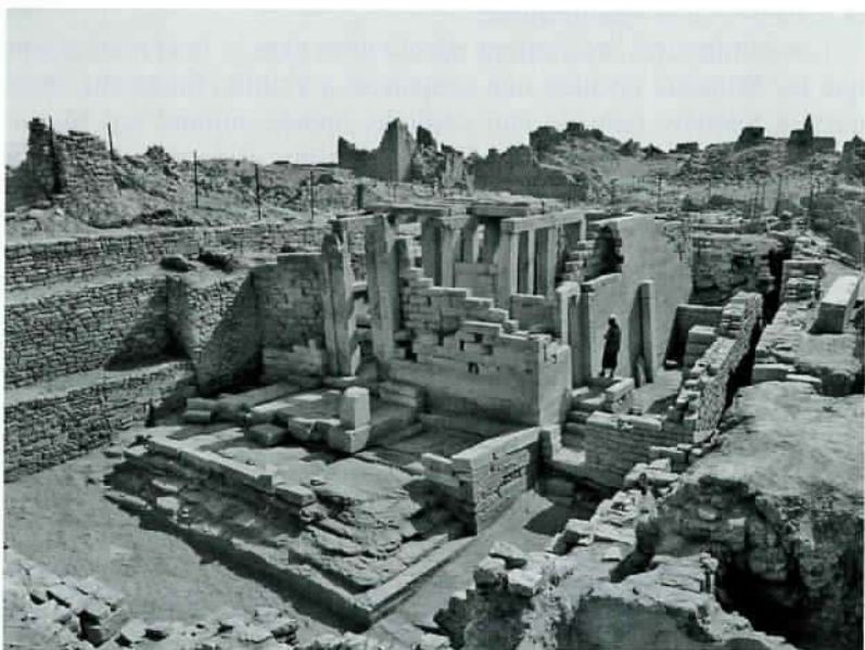
FIG. 2. – Le temple de Nakrah après sa restauration.
