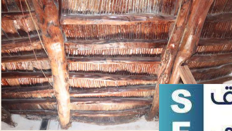
صورة سقف بيت الصلاة ويظهر فيها دعامة تحمل السقف
