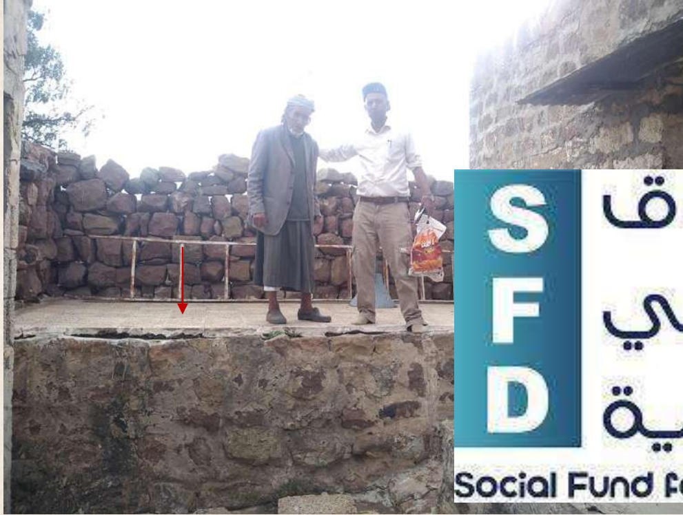
شكل 15 السهم يشير إلى مكان الصوح ويظهر في الصورة مبنى الحمامات.
