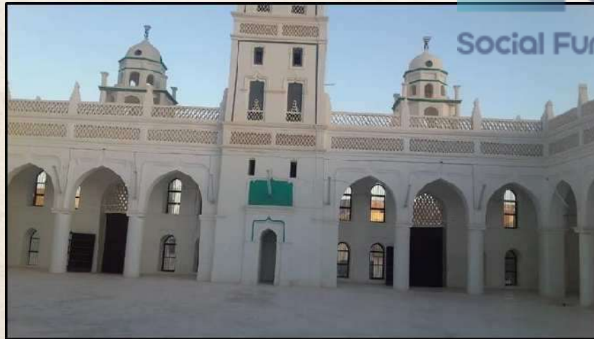
(صورة ٧٥) صورة للواجهة الداخلية للرواق المقابل لرواق القبلة (الرواق الشرقي الذي تركز عليه المئذنة)
