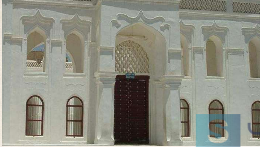
شبابيك وفتحات الواجهة الشرقية للمسجد (صورة ٣٦)
