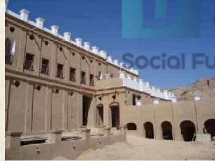
(صورة ٦٠) قصر الرناد من الداخل بعد الترميم
