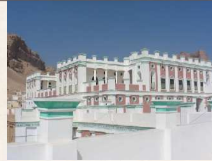
(صورة ٦٥) نموذج لسقف من قصر الرناد بعد الترميم
