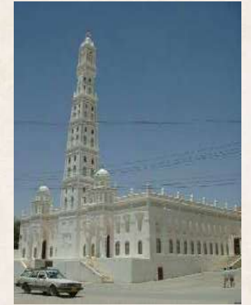
(صورة ٧٦) صورة للواجهة الرئيسية الشرقية - المصدر: العيدروس ٢٠٠٧
