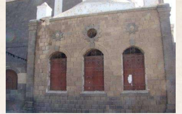
صورة رقم ١: الضريح الشمالي الواجهة الغربية
