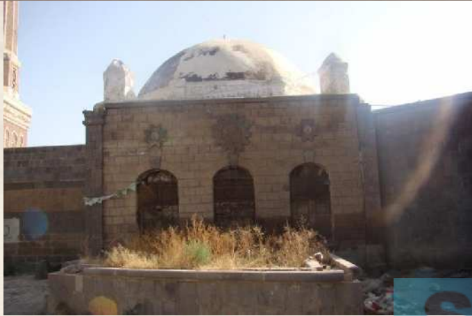
شكل (78) الضريح الجنوبي الواجهة الغربية
