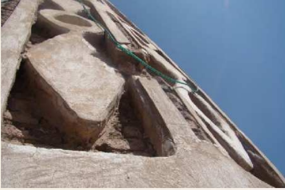
صورة ٤ : تساقط مكونات بدن المئذنة
