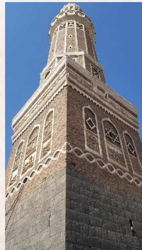
صور رقم ٥ : الواجهة الشرقية الجنوبية للمنذنة
