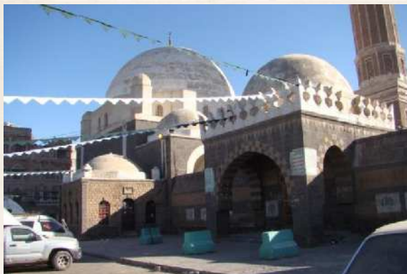
صور رقم ٢ : الواجهة الغربية لمدخل المدرسة
