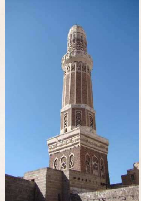
شكل (66) المئذنة - الواجهة الشرقية الشمالية
