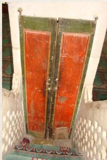
صورة رقم ٦: الواجهة الداخلية لباب المنبر
