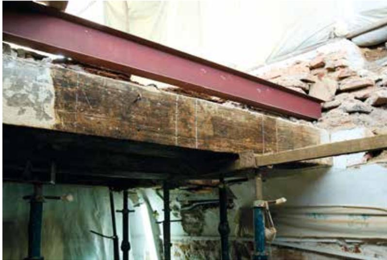
*Fig. 8.* Vista laterale di una trave a cui è stata agganciata una putrella di sostegno.
