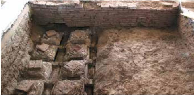
**Fig. 6.** Parte del soffitto aperto con il cassettonato a vista.
