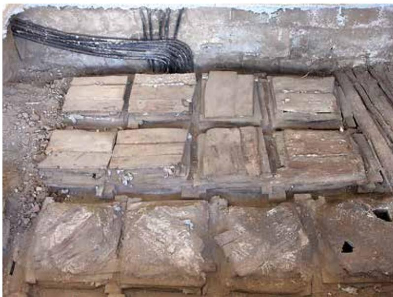
*Fig. 6.* Il cassettonato libero dal materiale di copertura.
