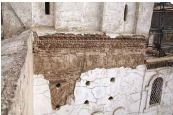
**Fig. 36** – Il minareto sud-est prima dell'intervento, particolare emerso dal crollo dell'intonaco soprastante della decorazione e dell'iscrizione a stucco.
