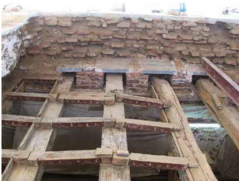
*Fig. 7.* Nell'immagine è visibile il sistema di travi e travetti a cassettonato smantellato.
