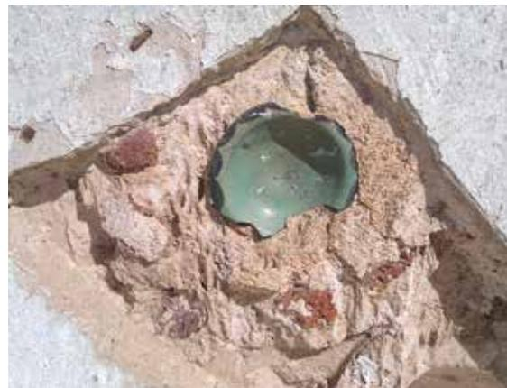
**Fig. 40, 41** – Minareto sud-est prima dell'intervento. Nelle immagini alcuni particolari dei saggi di pulitura in cui si evidenzia la presenza di alcuni elementi incastonati in ceramica verde.
