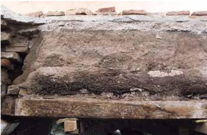
**Fig. 7.** Sezione stratigrafica della copertura del soffitto.
