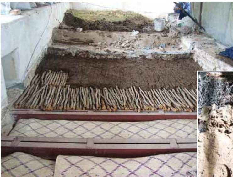
*Fig. 15.* Fase intermedia di richiusura del soffitto.
