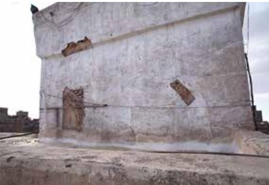
**Fig. 39** – Minareto sud-est prima dell'intervento. Sono stati eseguiti alcuni saggi stratigrafici di pulitura per l'indagine in merito a posizione, tipologia e stato di fatto dell'impianto decorative originale.
