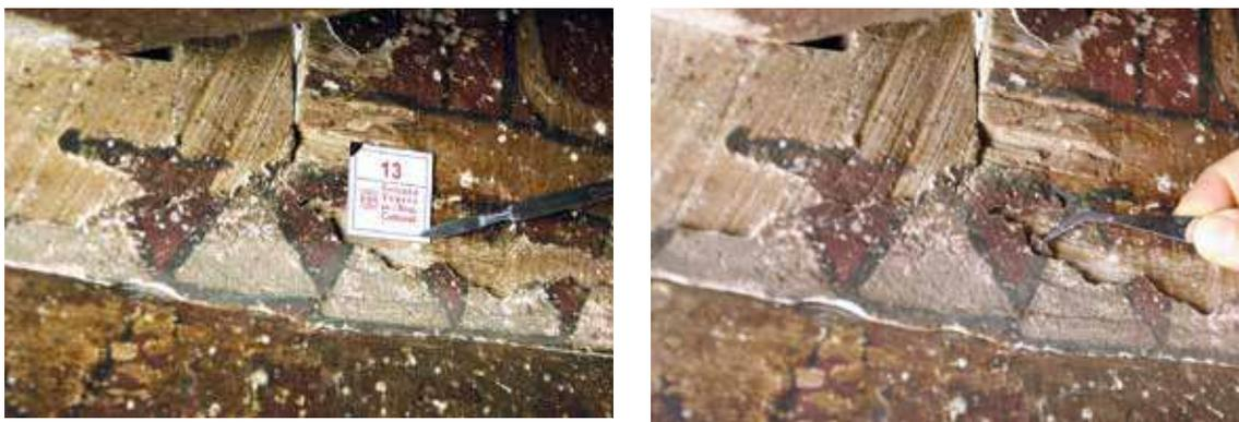
**Fig. 12, 13.** Identificazione del punto di prelievo e il momento di raccolta del campione di pellicola pittorica sollevata.
