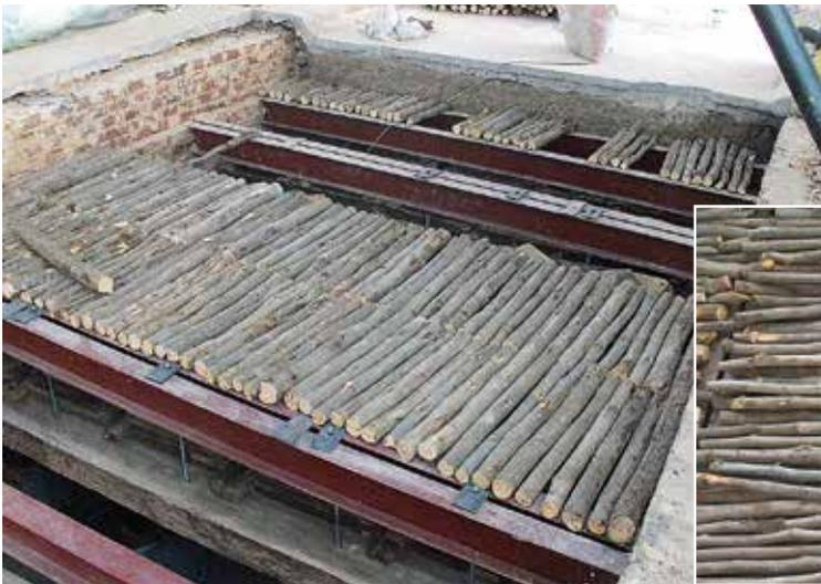
*Fig. 14.* Prima fase di richiusura del soffitto, posa.
