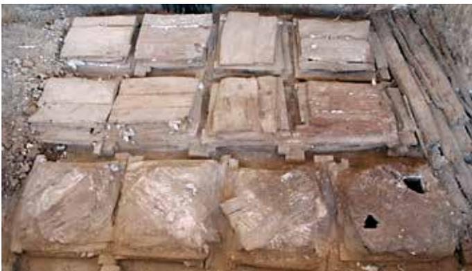
**Fig. 8.** Particolare del retro del soffitto cassettonato, visibile a seguito dell'apertura dall'esterno.
