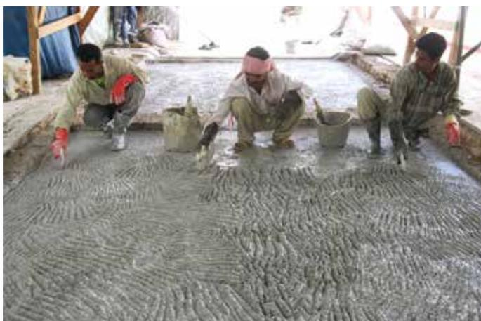
**Fig. 5.** Maestranza yemenita intenta nell'esecuzione di una delle stesure del *qadād*.
